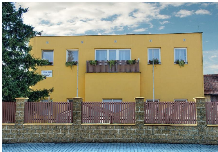
Obr. 2: Pohled na budovu TS
