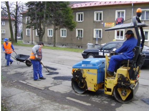
Obr.7: Likvidace výtluků teplou živicí
