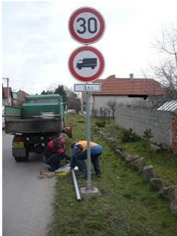
Obr. 1: Instalace dopravního značení – jedna z činností pracovníků TS
