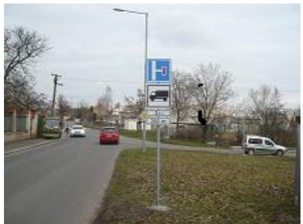
Obr. 10: Instalace dopravního značení, Liblice ul. Školní
