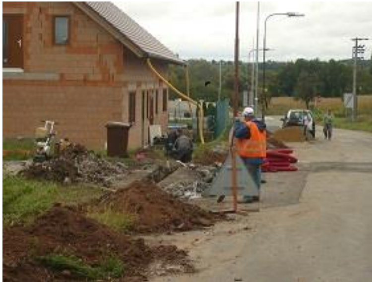
Obr. 3: Jedna z činností TS – rekonstrukce a správa veřejného osvětlení
