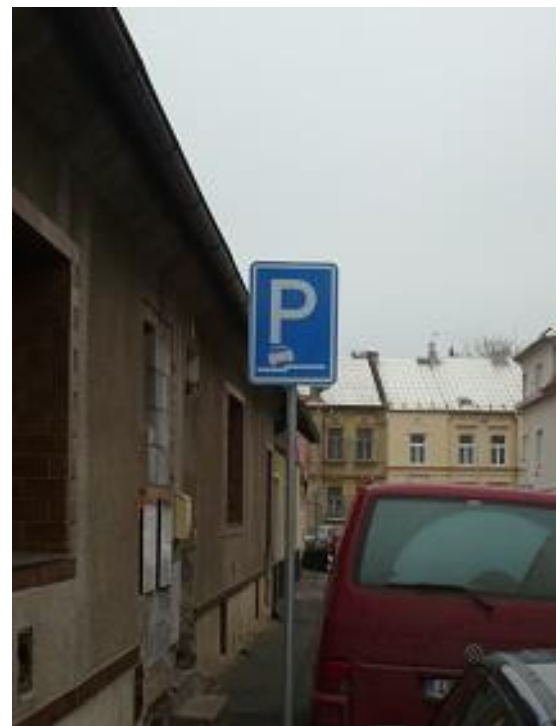
Obr. 12: Instalace svislého značení (ul. Želivského)
