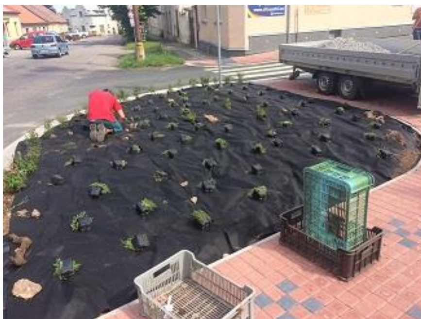
Obr. 23: Zakládání okrasného záhonu v ul. Bezručova
