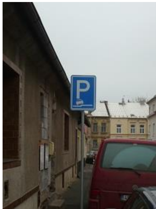
Obr. 12: Instalace svislého značení (ul. Želivského)
