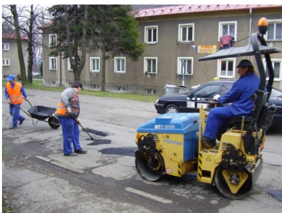
Obr.7: Likvidace výtluků teplou živicí
