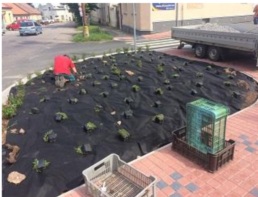
Obr. 23: Zakládání okrasného záhonu v ul. Bezručova
