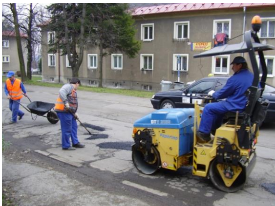
Obr. 7: Likvidace výtluků teplou živicí
