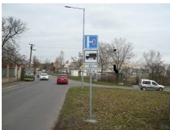
Obr. 10: Instalace dopravního značení, Liblice ul. Školní
