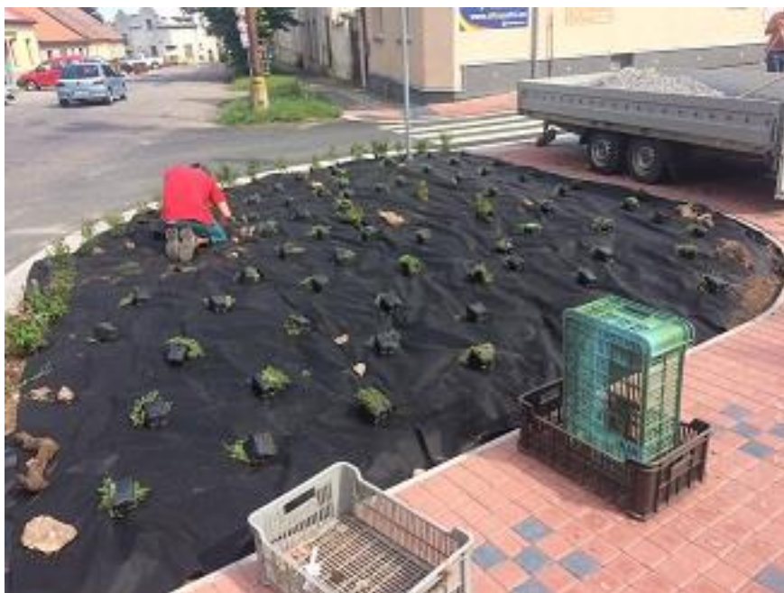
Obr. 23: Zakládání okrasného záhonu v ul. Bezručova
