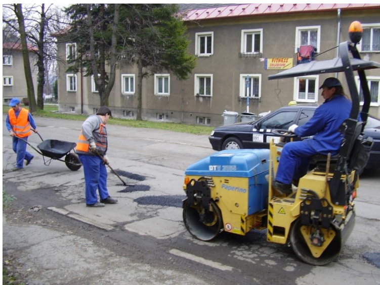
Obr.7: Likvidace výtluků teplou živici
