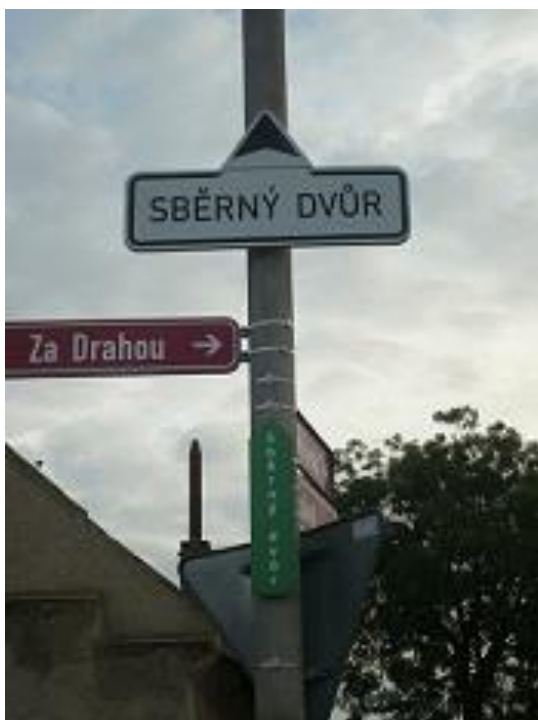
Obr. 11: Instalace svislého dopravního značení (Liblice)
