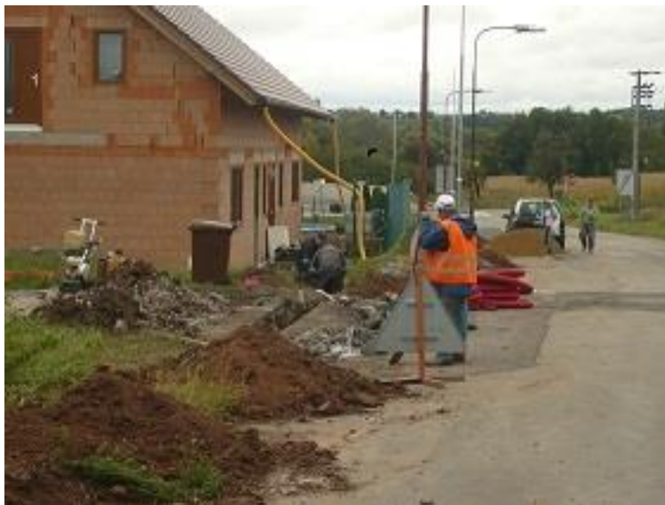
Obr.3: Jedna z činností TS-rekonstrukce a správa veřejného osvětlení
