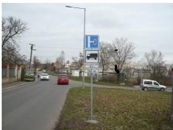
Obr.10: Instalace dopravního značení, Liblice ul. Školní
