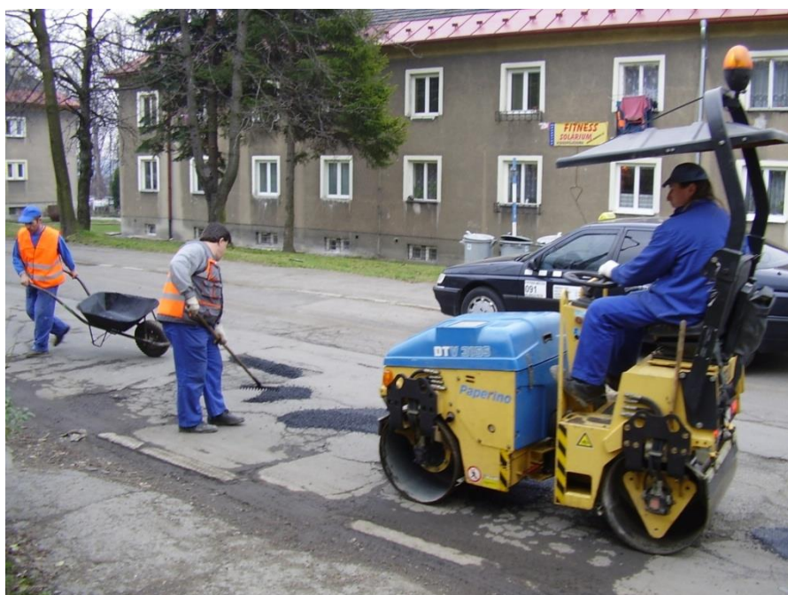
Obr.7: Likvidace výtluků teplou živicí
