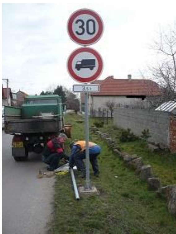
Obr.1: Instalace dopravního značení-jedna z činností pracovníků TS
