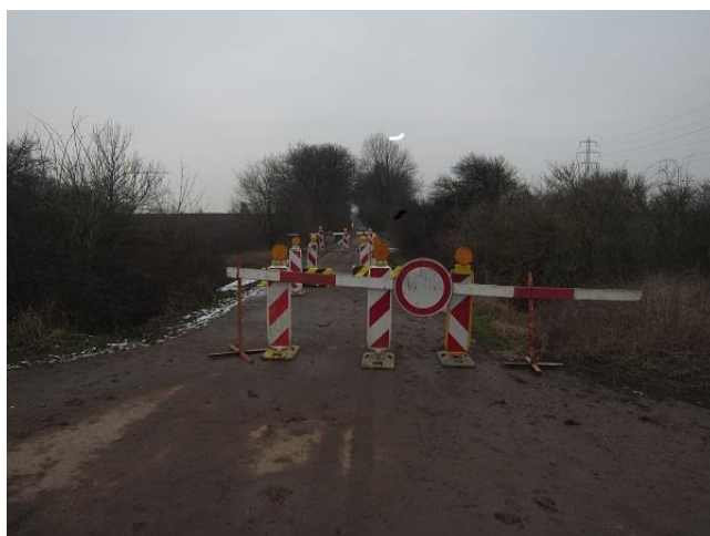
Obr.9: Zajištění uzavírky mostku na obslužné komunikaci Štolmíř-Kounice
