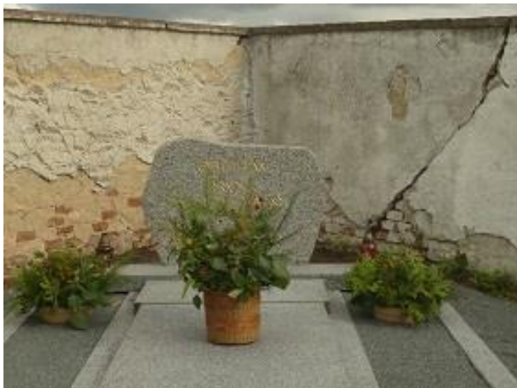
Obr.29: Oprava hrobového místa hrdinů z I. Světové války
