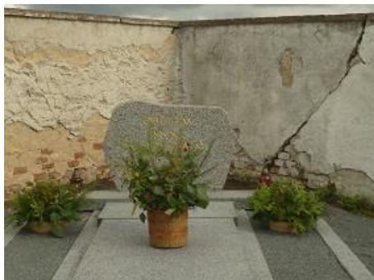
Obr. č. 19: Oprava Hrobového místa
