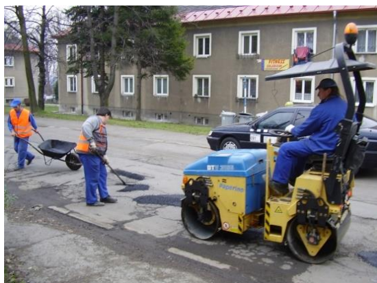
Obr. č. 4: Likvidace výtluků
