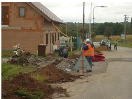
Obr. č. 18: Realizace veřejného osvětlení
