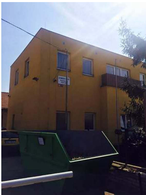
Obr. 1: Pohled na budovu TS
