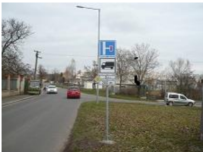
Obr. 10: Instalace dopravního značení, Liblice ul. Školní
