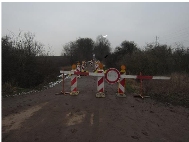
Obr. 9: Zajištění uzavírky mostku na obslužné komunikaci Štolmíř – Kounice
