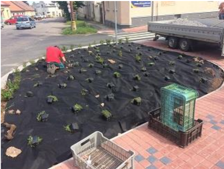
Obr. 23: Zakládání okrasného záhonu v ul. Bezručova
